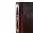
zaczep w skrzydle drzwiowym biernym
