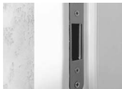
zaczep zamka magnetycznego w ościeżnicy
